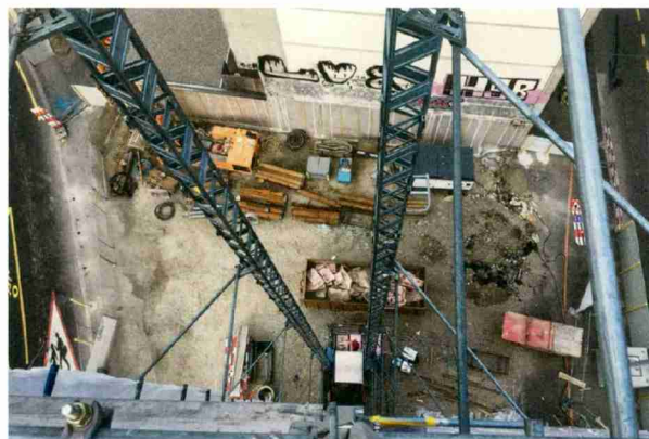
L'ancien bâtiment a été détruit pour faire place à terme à un ensemble de 14 étages.
