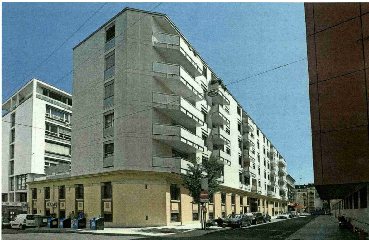
Les 8-10 de la rue Ferrier. La surélévation s'inscrit dans un tissu bâti pourtant hétéroclite. PHOTOS: RAINER SOHLBANK
