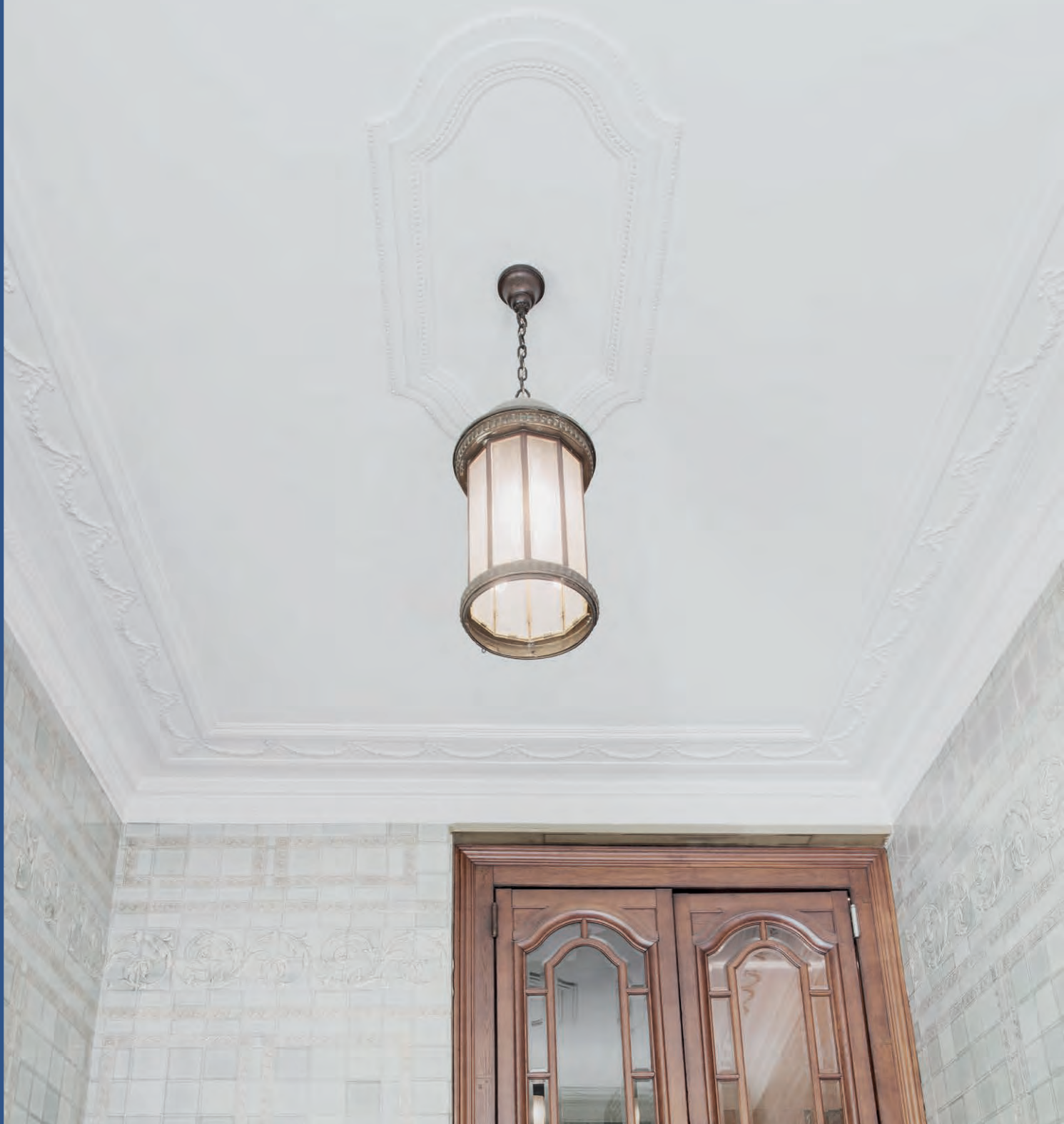
Hall d'entrée de l'immeuble sis av. Théodore-Weber 3 à Genève | Eingangshalle der Liegenschaft Av. Théodore-Weber 3 in Genf
