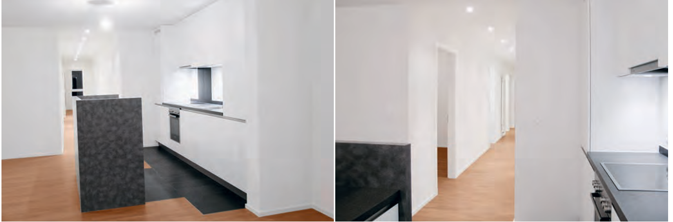
Création de 2 appartements en surélévation à l'av. Victor-Ruffy 51 à Lausanne. Bau von 2 Wohnungen durch Aufstockung der Liegenschaft an der av. Victor-Ruffy 51 in Lausanne.
