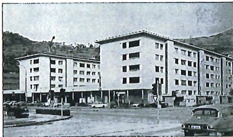
Rue St-Guérin 14-16-18, chemin du Vieux-Canal 35-37, Sion
