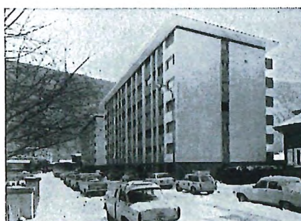
Avenue de la Moya 8-10 Martigny
