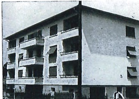
Rue du Cheminet 52 Yverdon
