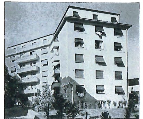
Rue de la Pontaise 25 Lausanne
