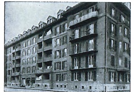
Rue de l'Eglise 2-4-6 Neuchâtel
