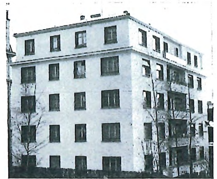
Rue de la Pontaise 21 Lausanne
