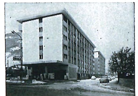
Avenue de la Moya 12-14 Martigny
