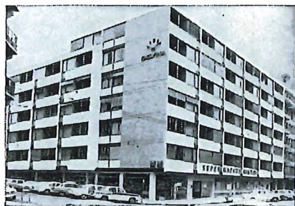
Rue des Pâquis 39-41, rue du Môle 2-4, Genève
