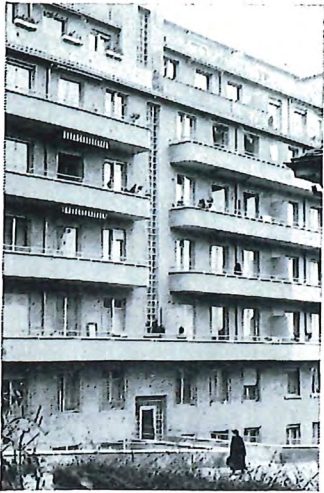
Chemin des Aubépines 5 Lausanne
