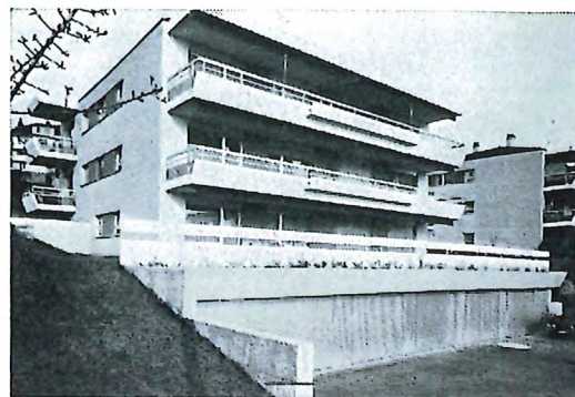
Chemin du Faux-Blanc 20F Pully
