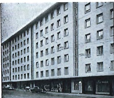
Rue de la Maladière 16-18-20 Neuchâtel
