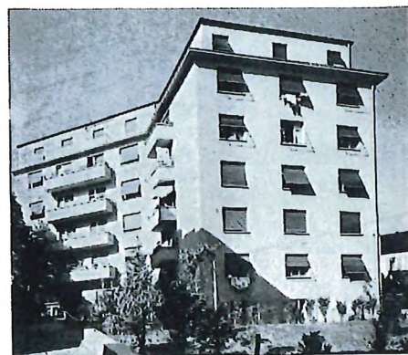
Rue de la Pontaise 25 Lausanne
