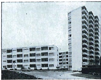
Rue de Vevey 45A et B, rue du Tirage 2 rue des Agges 2, Bulle
