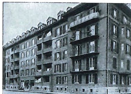
Rue de l'Eglise 2-4-6 Neuchâtel
