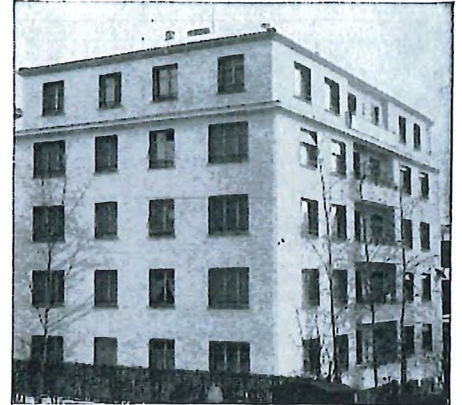
Rue de la Pontaise 21 Lausanne
