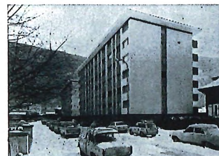
Avenue de la Moya 8-10 Martigny
