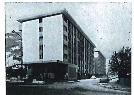
Avenue de la Moya 12-14 Martigny
