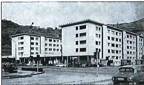
Rue St-Guérin 14-16-18, chemin du Vieux-Canal 35-37, Sion
