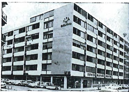
Rue des Pâquis 39-41, rue du Môle 2-4, Genève
