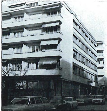
Chemin des Rosiers 4 Lausanne
