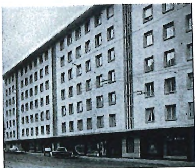
Rue de la Maladière 16-18-20 Neuchâtel
