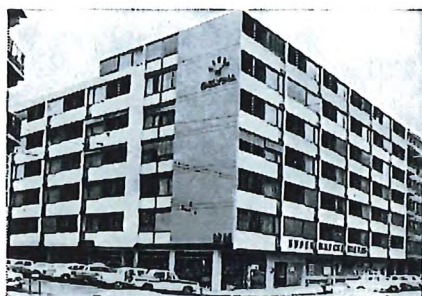
Rue des Pâquis 39-41, rue du Môle 2-4, Genève
