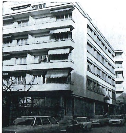
Chemin des Rosiers 4 Lausanne
