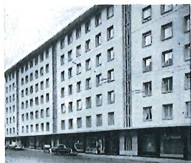
Rue de la Maladière 16-18-20 Neuchâtel
