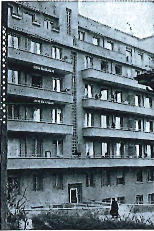
Chemin des Aubépines 5 Lausanne
