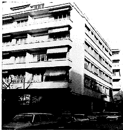
Chemin des Rosiers 4 Lausanne
