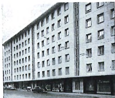
Rue de la Maladière 16-18-20 Neuchâtel
