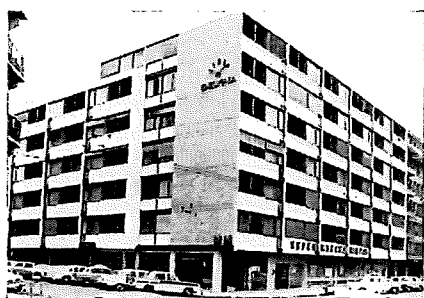
Rue des Pâquis 39-41, rue du Môle 2-4, Genève
