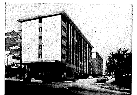
Avenue de la Moya 12-14 Martigny
