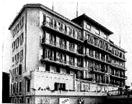
Avenue des Alpes 46 La Tour-de-Peilz
