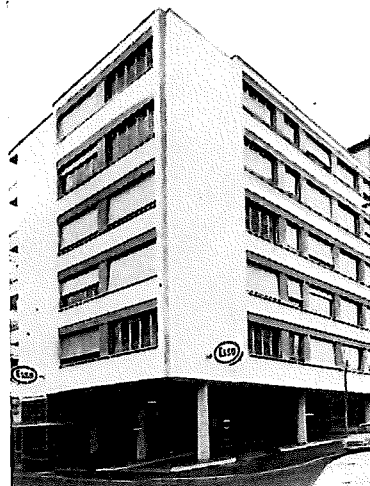
Chemin des Rosiers 2 Lausanne
