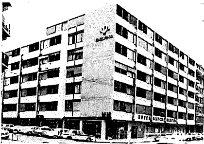
Rue des Pâquis 39-41, rue du Môle 2-4, Genève
