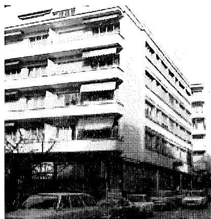
Chemin des Rosiers 4 Lausanne
