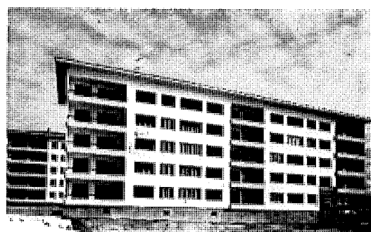
Chemin St-Guérin 14-16-18 Chemin du Vieux-Canal 35-37 Sion
