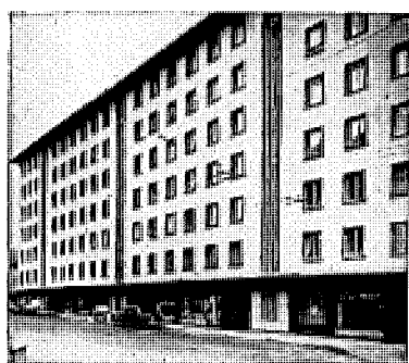
Rue de la Maladière 16, 18, 20 Neuchâtel
