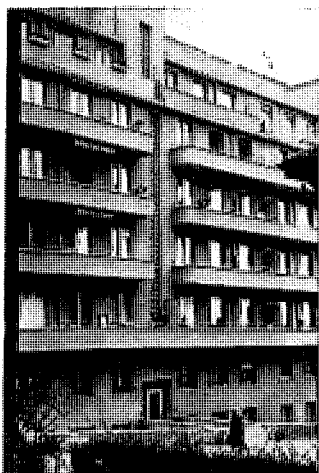
Chemin des Aubépines 5 Lausanne
