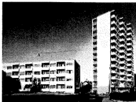
Rue de Vevey, rue du Tirage Bulle
