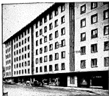
Rue de la Maladière 16, 18, 20 Neuchâtel
