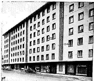
Rue de la Maladière 16, 18, 20 Neuchâtel
