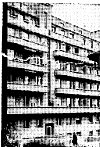
Chemin des Aubépines 5 Lausanne
