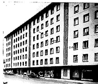
Rue de la Maladière 16, 18, 20 Neuchâtel
