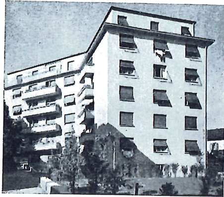
Rue de la Pontaise 21 Lausanne
