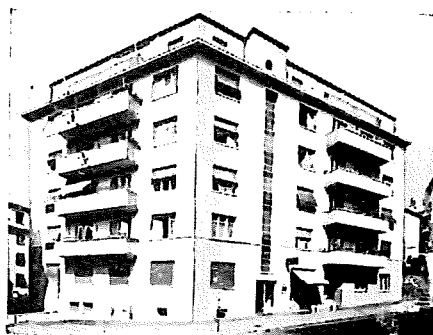
Rue de la Pontaise 25 Lausanne
