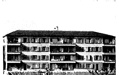
6-8, Chemin du Suchiez 10-12 Neuchâtel
