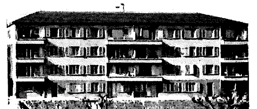
6-8, Chemin du Suchiez 10-12 Neuchâtel
