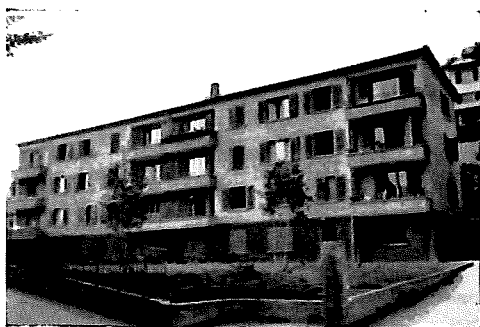
Chemin du Suchiez 6-8 Neuchâtel
