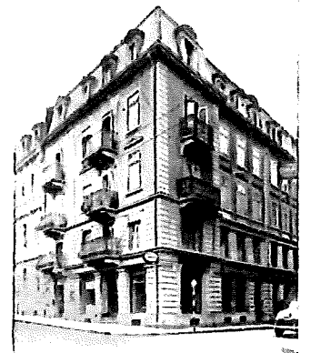
Rue de la Banque 10 Freiburg
