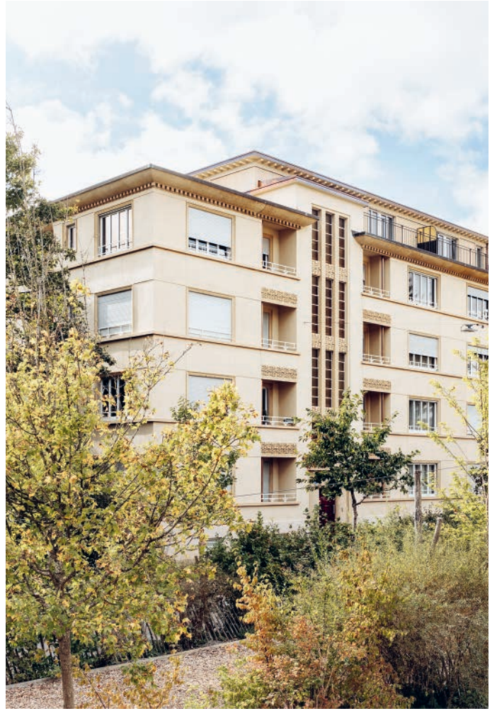
→ Avenue de Béthusy 82 – 84, Lausanne
