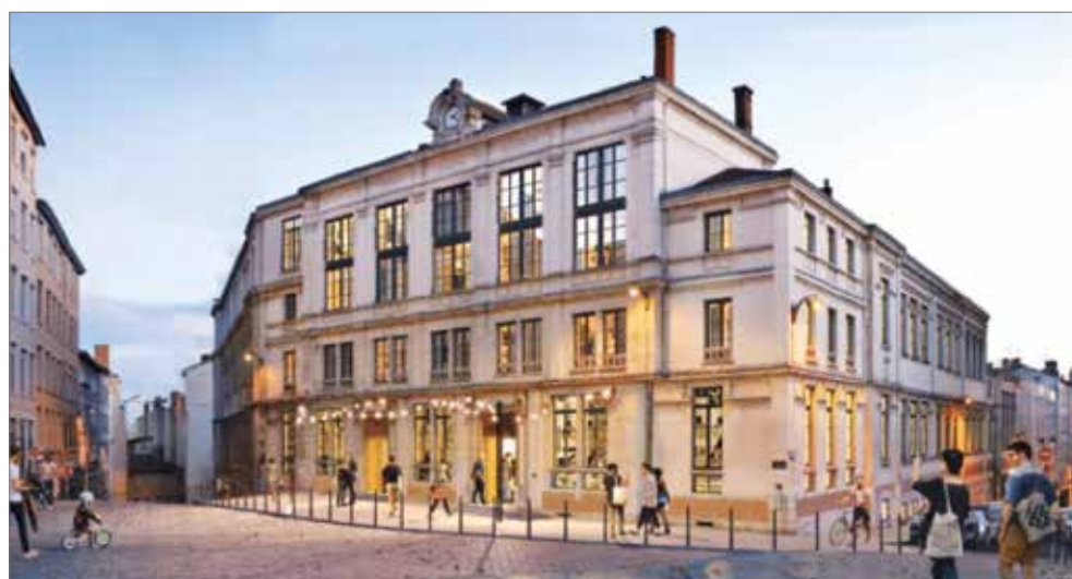
Lors de la réhabilitation par Linkcity du Collège Truffaut (Lyon) en un lieu de vie multi-usages dédié à la jeunesse, de nombreux matériaux ont été réemployés in situ et sur d'autres projets.
