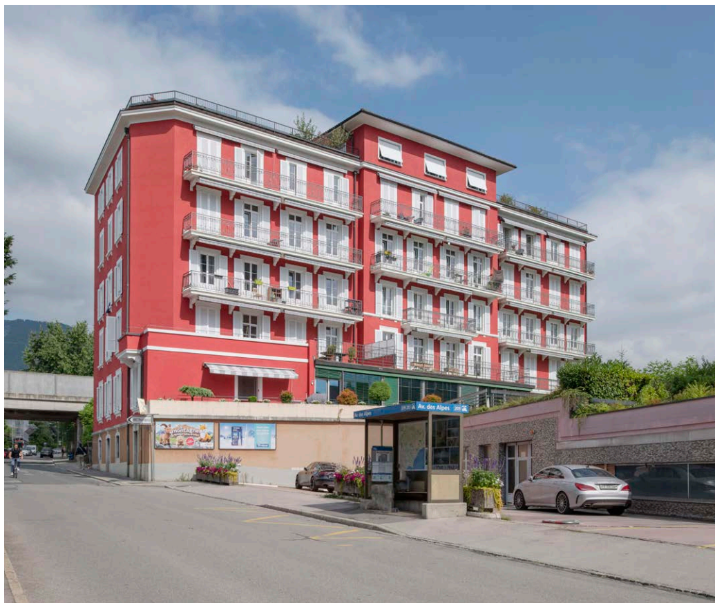
La Tour-de-Peilz, avenue des Alpes 46–48 Réfection de la façade de l'immeuble.
