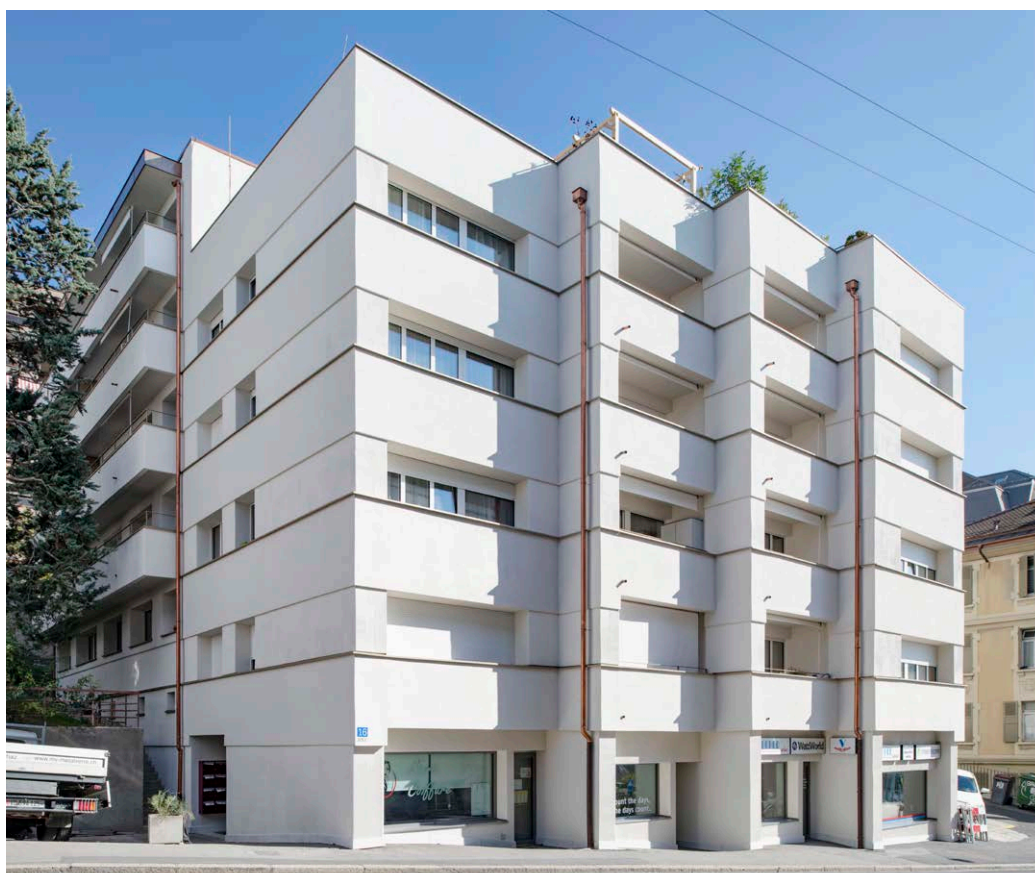
Lausanne, avenue Recordon 16 Rénovation de la façade de l'immeuble avec la pose d'une isolation périphérique.
